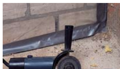
Zaštita PE-plastičnog filma sa tesa® 4613.
